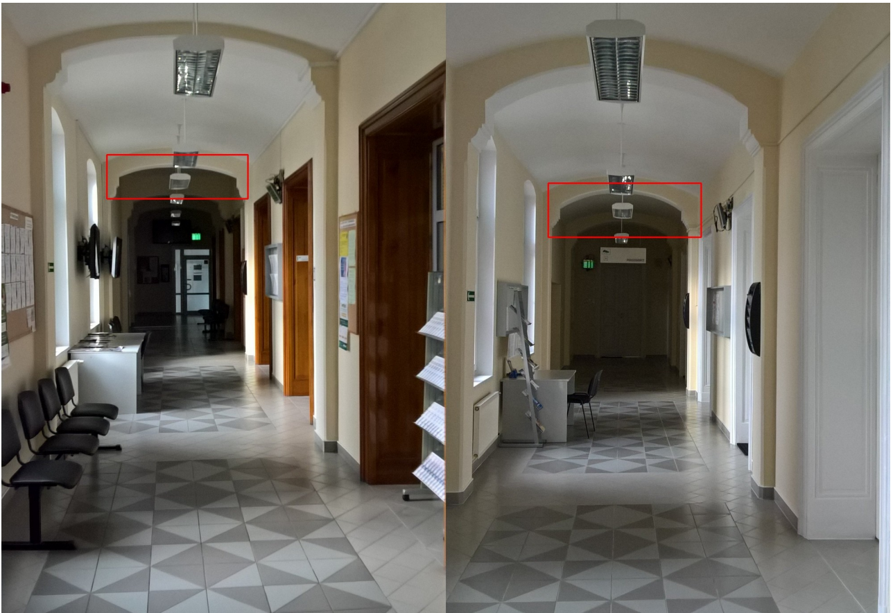
Korytarze: z lewej parter, z prawej I piętro. W obwódkach zaznaczone miejsce montażu nowych wyświetlaczy
